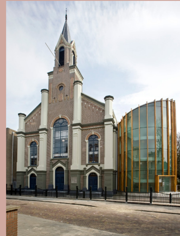
Remonstrantse kerk Groningen, huisvesting SOGK
