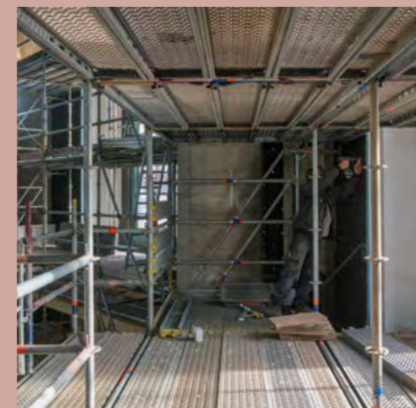
Het plaatsen van de wandverwarming.
